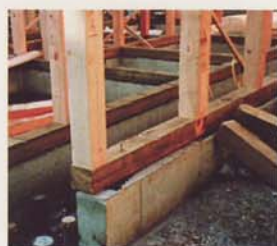
基礎工事の不良により土台に生じたスレ
